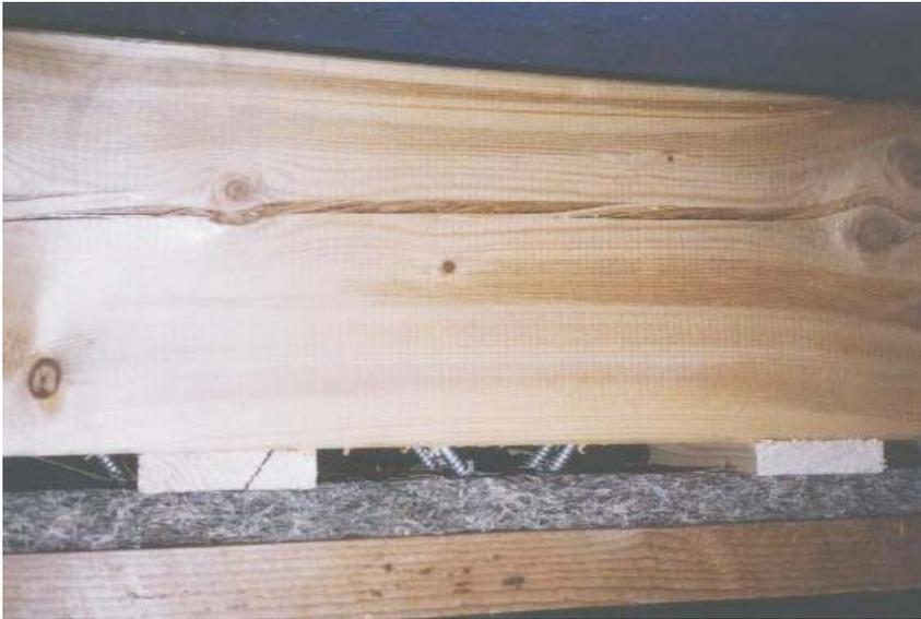
Schubfeste Verschraubung des unterspannten Balkens
